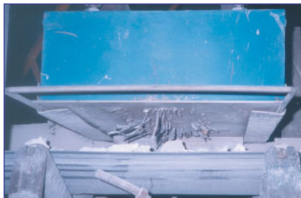
As impurezas ferrosas capturadas ficam retidas no Suspensão, longe do material transportado
